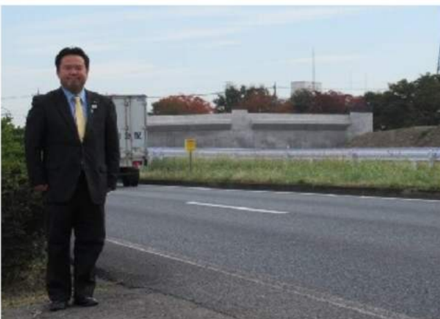
一般国道和光富士見バイパスは、浦所バイパスとぶつかる下南畑交差点にて立体交差工事が進む。
