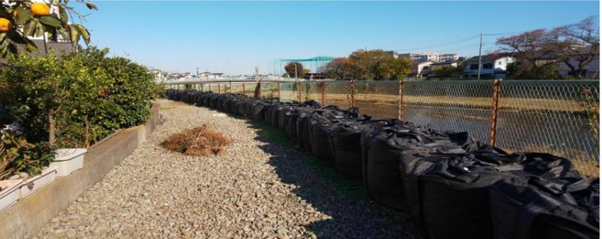
台風19号では、高橋周辺の左岸側で一部越水や漏水があり、伏流水も吹き出した事によって浸水被害が発生いたしました。折角積んだ土のうからも、水漏れもあつたり、高橋下流に以前造られたコンクリート壁からの漏れも確認されました。そこで、県としては越水した箇所でも土嚢を積み増し、盛り土もした上で、土のうをシート巻にして水漏れを防止する対策、伏流水で穴の開いた場所に固化材を注入する対策を行います。コンクリート壁の漏水に対しては、すでに穴埋め工事を行い終了いたしました。
