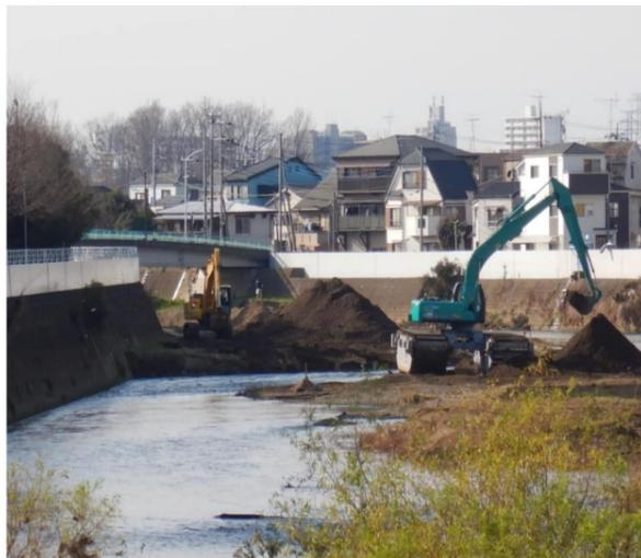
柳瀬川の水害対策の一環として、柳瀬川の河道掘削（洪水時の水位を低下させるため、河道を掘って水が流れる面積を広くする）工事が柏町にある高橋上流から旧市役所庁舎の脇を超え先栄橋の下流まで進められる予定で、すでにスタートいたしました。令和元年度と令和二年度の二カ年で約800m区間を計画しております。
